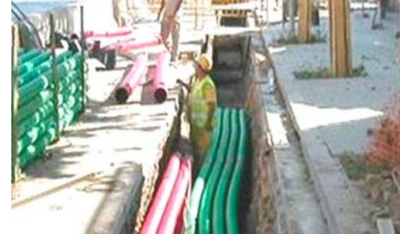
Nuevas redes de energía y telecomunicaciones
