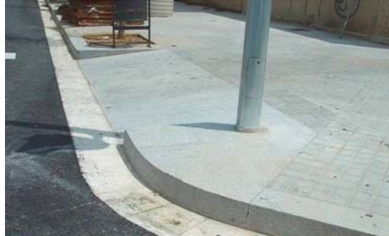
Renovación del espacio público
