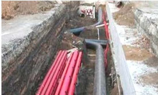
Recogida neumática selectiva de residuos
