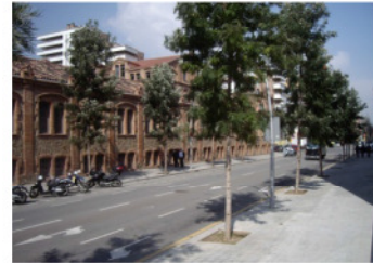
Vía primaria. Calle Tánger
