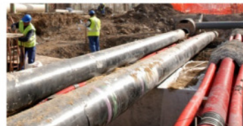
Nueva red de infraestructuras avanzadas
